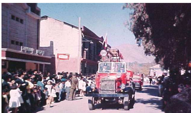
Carros de Bombas que prestaron servicio a la comunidad elquina.
