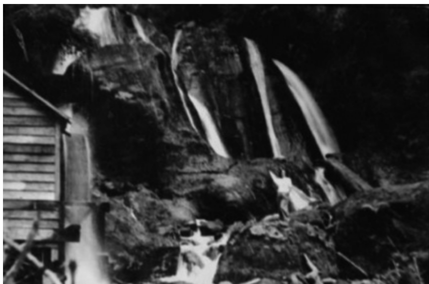
Foto: Turbina que daba luz al hotel. Fotografía de Rodolfo Navarro.
