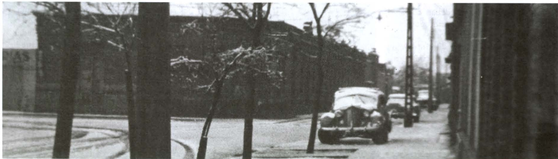
Calle Maipú, altura 1.100. Nevada de 1964. Barrio Yungay.
