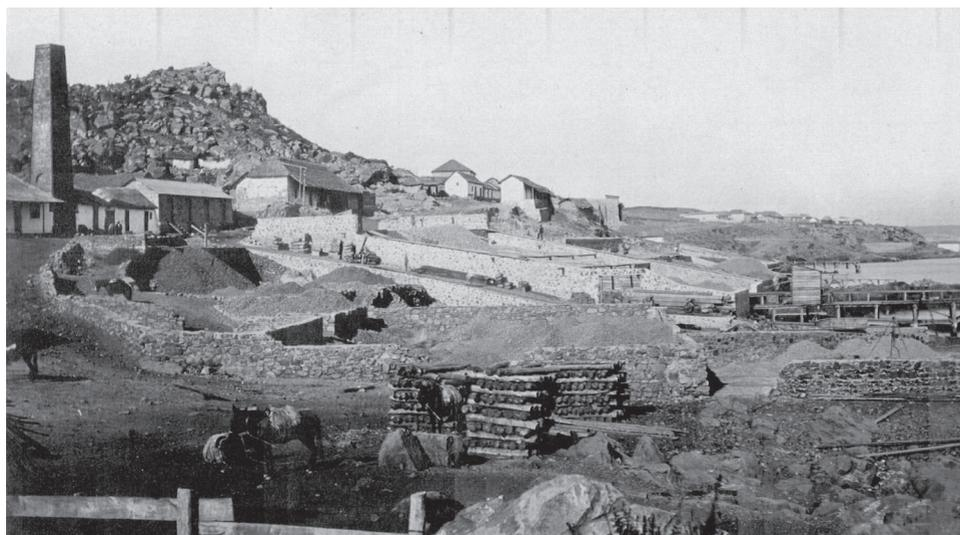
Fundición Errázuriz Urmeneta. Patio de escoria de la fundición, donde se acumulaba el mineral traído de Tamaya para fundirlo. Se aprecian los hornos, las mulas y se ve el muelle donde embarcaban el mineral. Tongoy, 1860 aprox.
