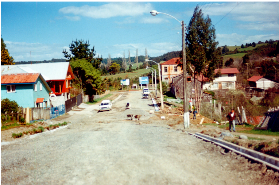
Calle principal German Wulf durante los trabajos previos a su pavimentación. 1997.
