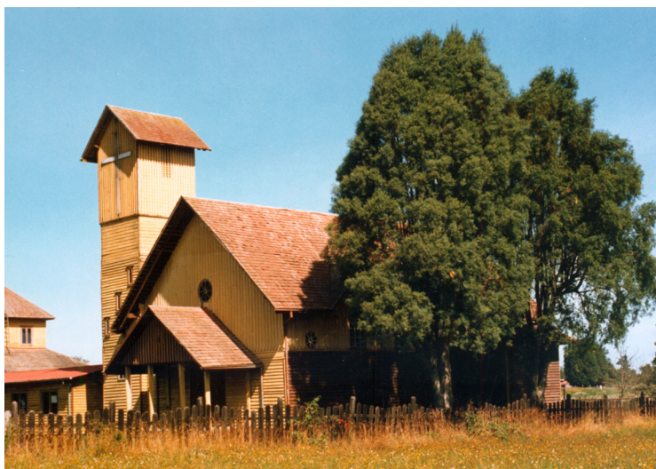
Templo católico de la parroquia San Pedro Apóstol de Rupanco. Un incendio lo destruyó el lunes 18 de abril del año 2016. Fotografía de 1988. Donante: Víctor Eduardo Vidal Mancilla
