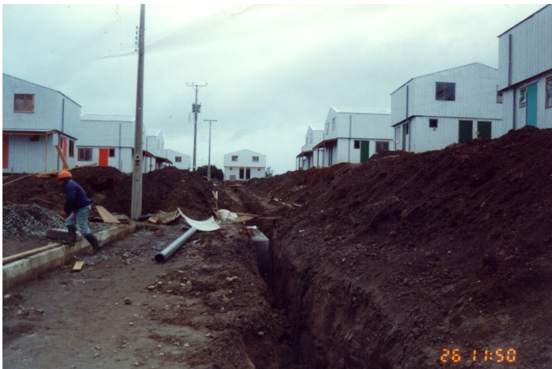
Instalación de la red de alcantarillado en Población Playa Raquel; calle principal Los Alerces. 1997.
