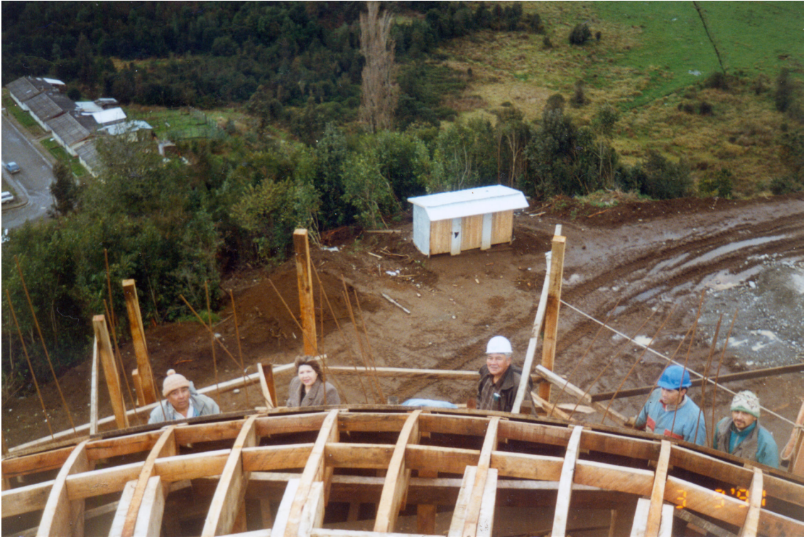
Construcción de la copa de agua de la población Playa Raquel. La alcaldesa Carmen Ortiz Ojeda realiza tareas de inspección. 3 de septiembre de 1997.
