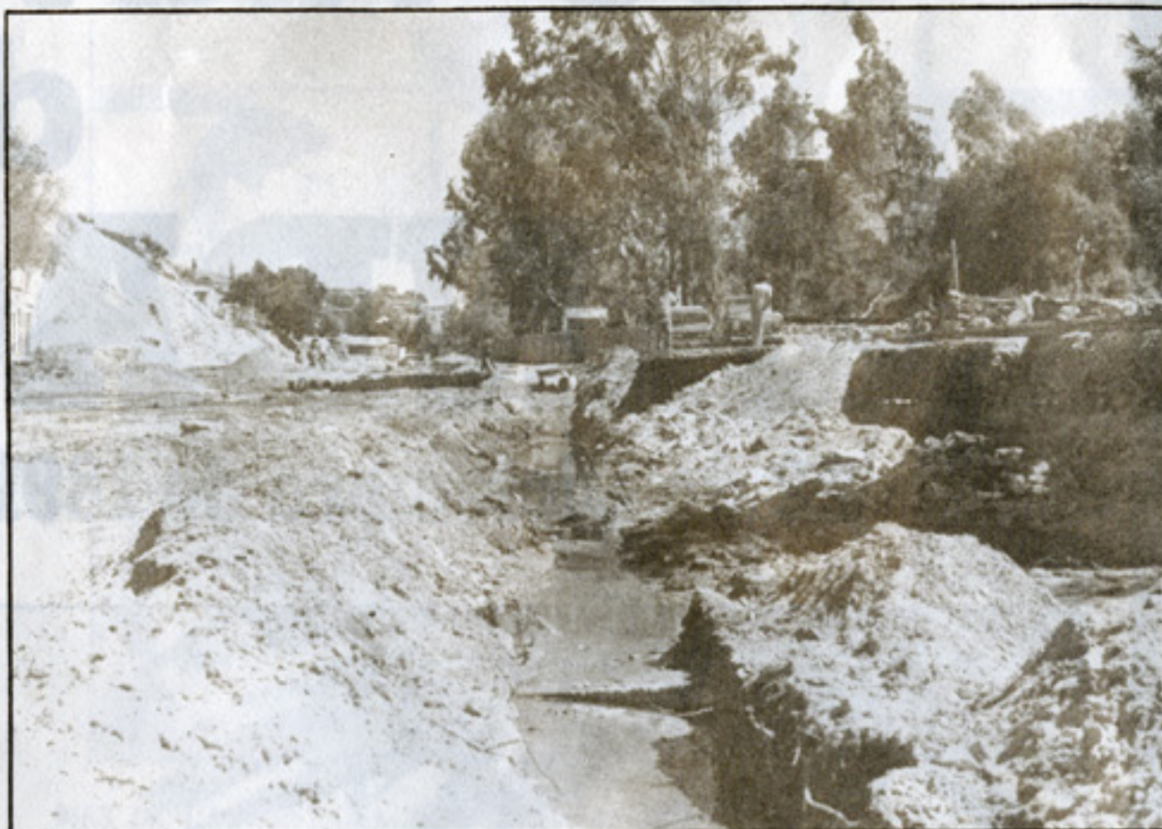
OBRAS: Continuamente la Dirección de Obras de la I. Municipalidad ejecuta reparaciones de las principales vías de tránsito vehicular y peatonal de la ciudad. La Avenida Costanera está en los proyectos de 1987.
