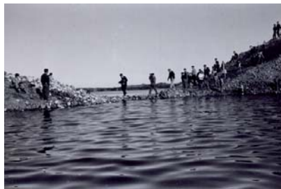
Construcción del piedraplén. Calbuco. Marzo- abril de 1966. Donada por Manuel López Léniz.
