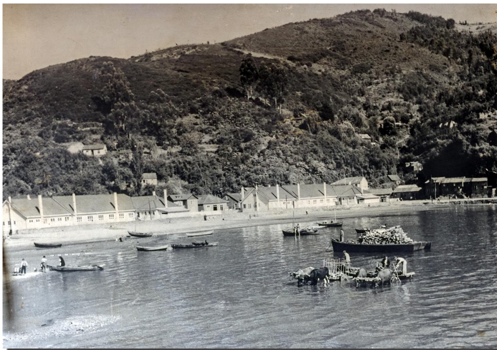
Grupo Escolar formado por las Escuelas N° 12 de hombres y N° 13 de mujeres, ambas construidas por la Sociedad Constructora de Establecimientos Educativos. Corral, década del 40. Donante: Herminio Aja Palma
