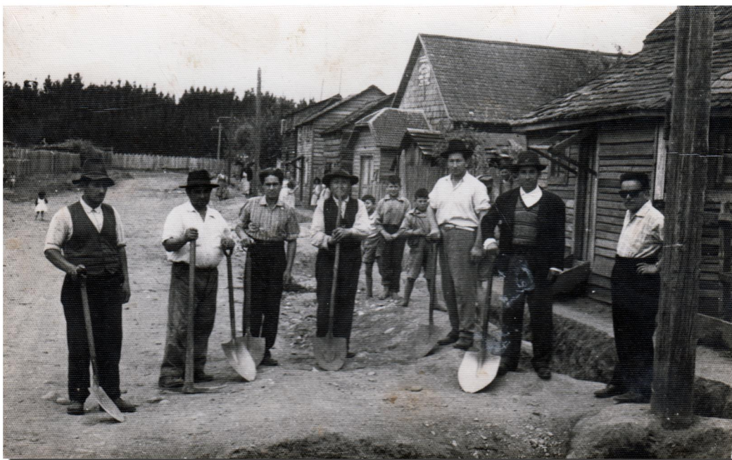
Instalación de agua potable en la calle Eduardo Zárate. Los trabajadores eran los mismos vecinos y los niños aprovechaban de jugar en medio de los trabajos. Los Lagos, años 60. Donante: Olimpia Iturra Balmazábal
